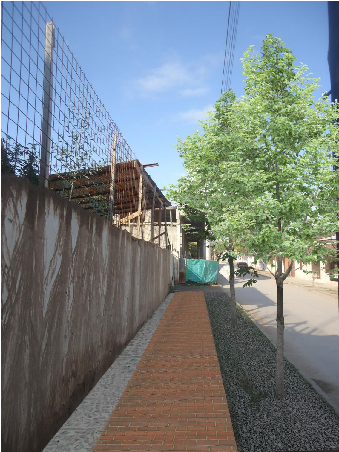
Vereda angosta con franja de piedra bola chica con junta tomada y franja de tierra con grava.
